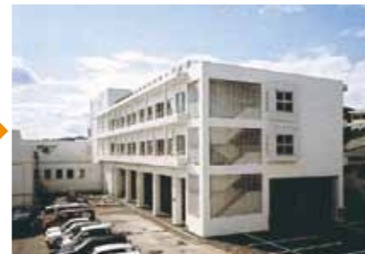
平成15年、南病棟が完成。
